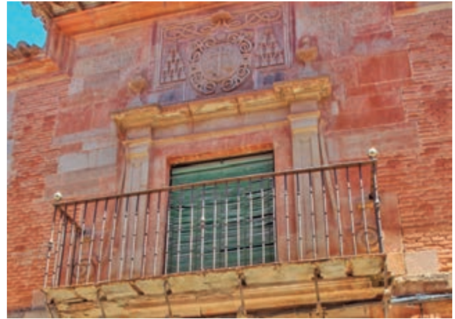
Casa Cuartel de Los Caballeros de Santiago en Villanueva de los Infantes, construida en 1749, según atestigua la inscripción de la fachada: “Casa del Insigne e Real Convento de Uclés Cabeza del Orden de Santiago...”
